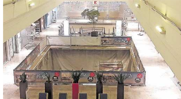
Der Deckendurchbruch bringt mehr Transparenz. FOTOS (2) PRIVAT
