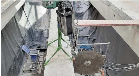
Mit hoher Präzision wurde an dem Lichthof gearbeitet.
